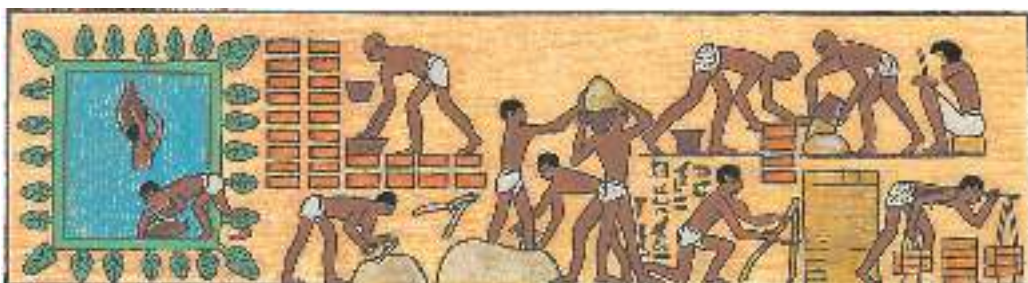
Строительство дома. Древнеегипетская роспись.
